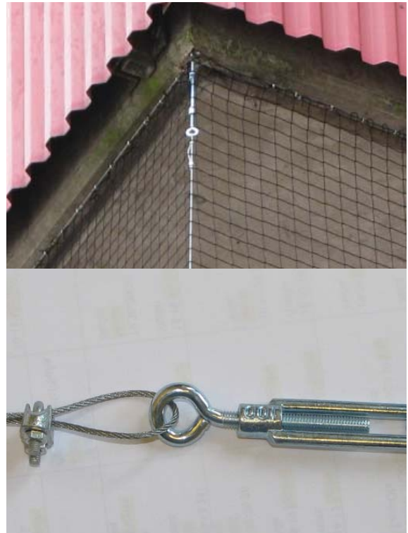
Wire fäst i vantskruv med wirelås
